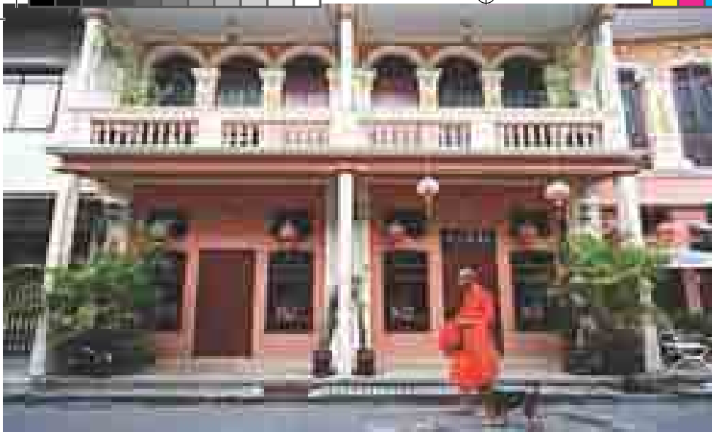
อาคารซิโน-โปรตุกีส ในจังหวัดภูเก็ต ที่มีเสน่ห์และงดงาม
