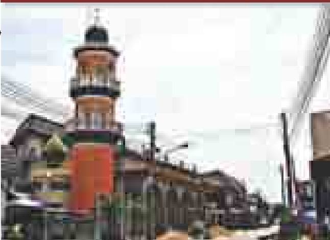
มัสยิดกลาง ต.ปากพะยูน อ.ปากพะยูน จ.พัทลุง
