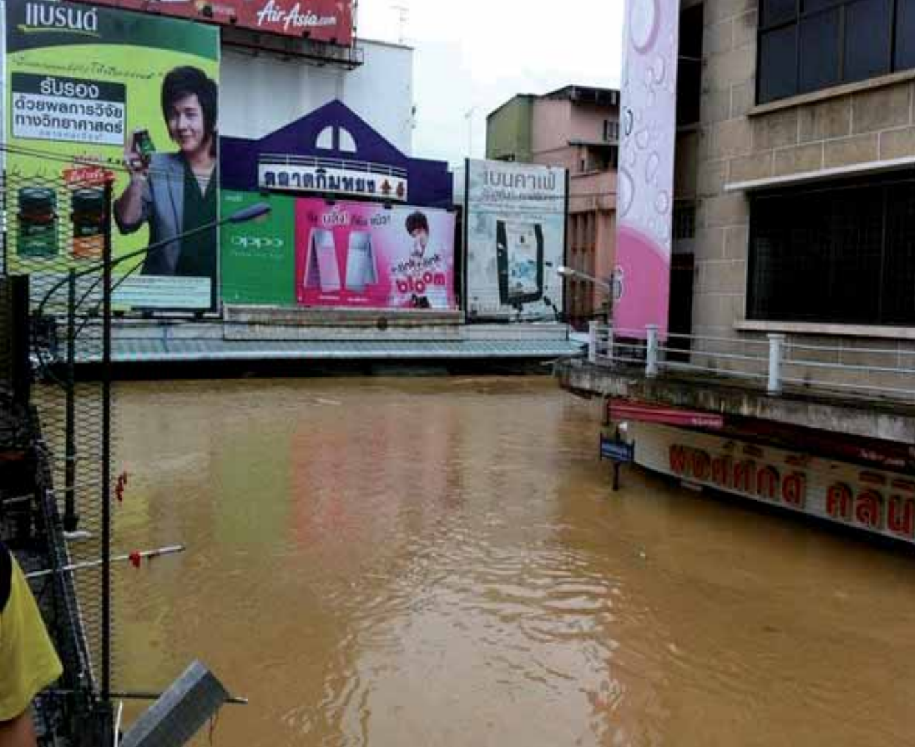
ตลาดกิมหยง 1-2 พฤศจิกายน 2553 ระดับน้ำสูงกว่า 2.0 เมตร
