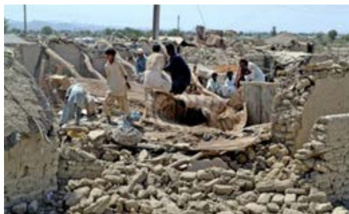
ภาพที่ 1 ความเสียหายที่เกิดจากเหตุการณ์แผ่นดินไหวปากีสถาน ในวันที่ 24 กันยายน 2556
