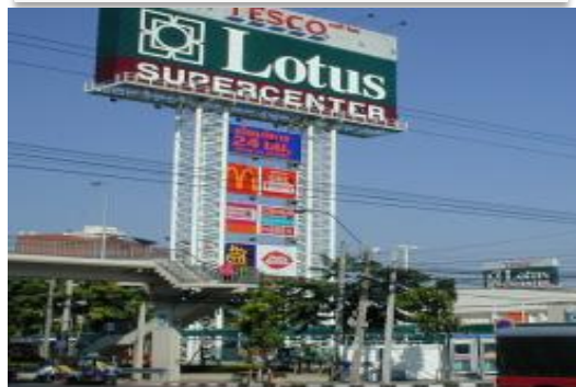
ติดตั้งป้าย
