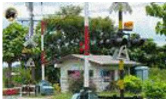
ทำงานทางเชื่อม ผ่าน ทางรถไฟ
