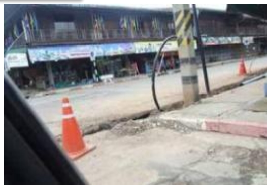
ระบายนํ้าลงเขตทาง
