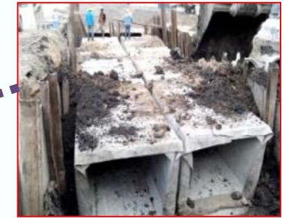
วางท่อระบายน้ำ ทล.2032 (ยธ.)
