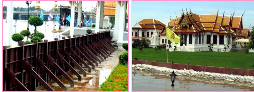
คันป้องกันน้ำท่วมแบบแผงเหล็ก พระตำหนักสิริยาลัย จ.อยุธยา
