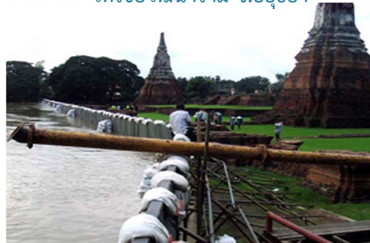
คันป้องกันน้ำท่วมแบบแผ่นคอนกรีตสำเร็จ วัดไชยวัฒนาราม จ.อยุธยา
