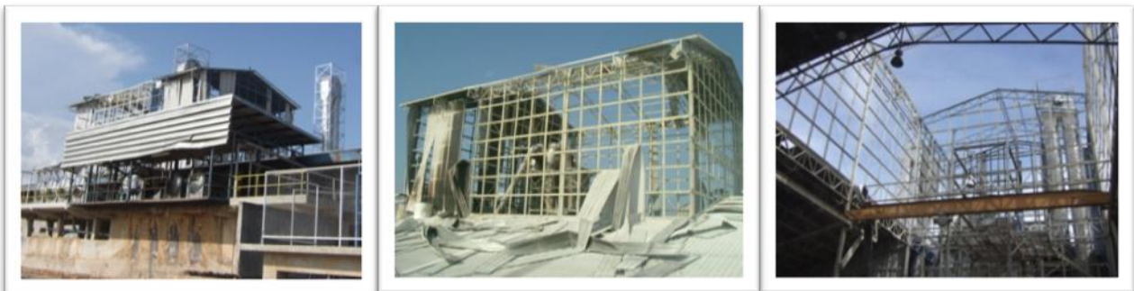
รูปที่ 1.2 แสดงอาคารโรงงาน บริเวณไซโคลนเย็น และห้องบรรจุแป้งเสียหายจากการระเบิด
