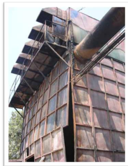
รูปที่ 1.6 แสดงการปริแตกของไซโลเก็บฝุ่นไม้
