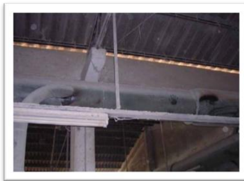
รูปที่ 1.9 แสดงรอยไหม้ที่ท่อดูดฝุ่นจากเครื่อง Sander Machine
