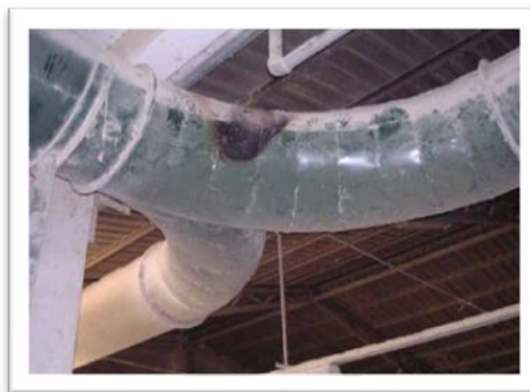
รูปที่ 1.10 แสดงรอยไหม้จากท่อดูดฝุ่นจาก Sander Machine
