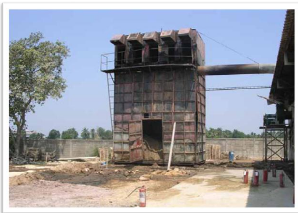
รูปที่ 1.5 แสดงความเสียหายของไซโลเก็บฝุ่นไม้
