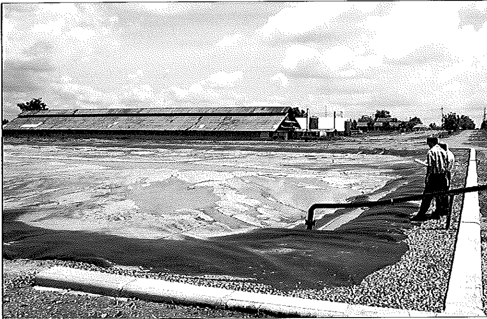
ภาพประกอบ 2.10 การบำบัดน้ำเสียฟาร์มสุกรด้วยระบบบำบัดแบบ Cover Lagoon ที่มา: คัดแปลงจาก มุลนิธิพลังงานเพื่อสิ่งแวดล้อม, 2550
