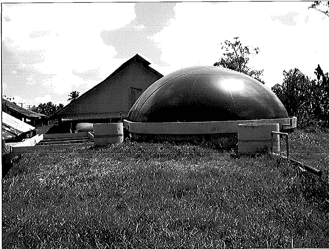
ภาพประกอบ ง 1 ระบบบำบัดมลพิษฟาร์มที่ 1
