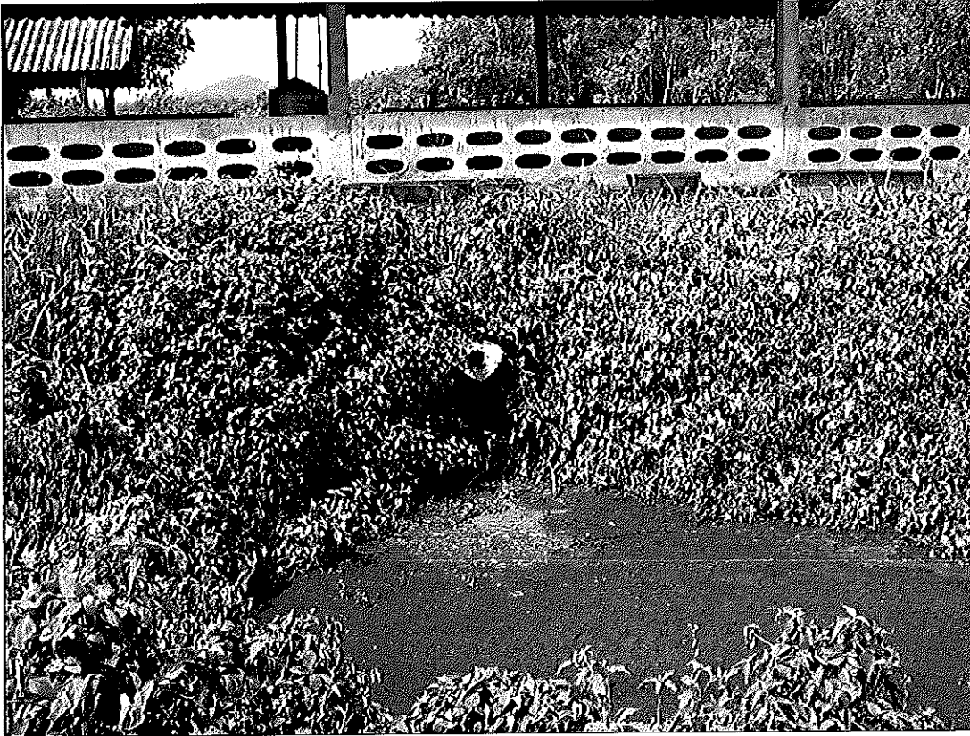
ภาพประกอบ ง 6 ระบบบำบัดมลพิษฟาร์มที่ 6
