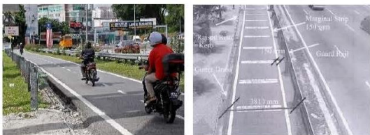
รูปที่ 3 ตัวอย่างการจัดช่องจราจรเฉพาะสำหรับรถจักรยานยนต์ (Exclusive Lane)
