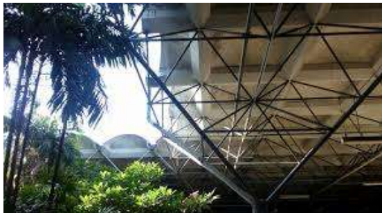
(ข) โครงสร้างเหล็กถัก
