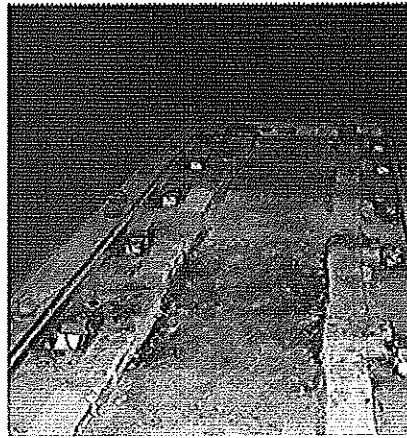
รูปที่ 6.11 การติดตั้งเครื่องตดตะกอนเชิงไฟฟ้าสถิตเพื่อทดสอบการใช้งานในห้องรมยาง
