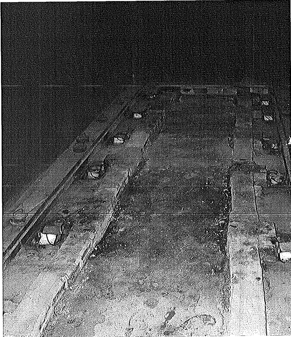
รูปที่ ผณ.5 เครื่องตกตะกอนเชิงไฟฟ้าสถิตภายในห้องรมยางหลังการปรับปรุง
