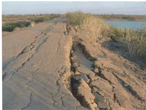
รูปที่ 2.17 แรงสั่นสะเทือนของแผ่นดินไหวก่อให้เกิดรอยแตกขนานกับแกนเขื่อน (สุทธิศักดิ์, 2550)
