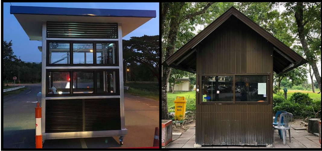
ภาพที่ (จ.1.1) ป้อมตรวจบุคคลเข้า-ออก (โคกเหล็ก)
