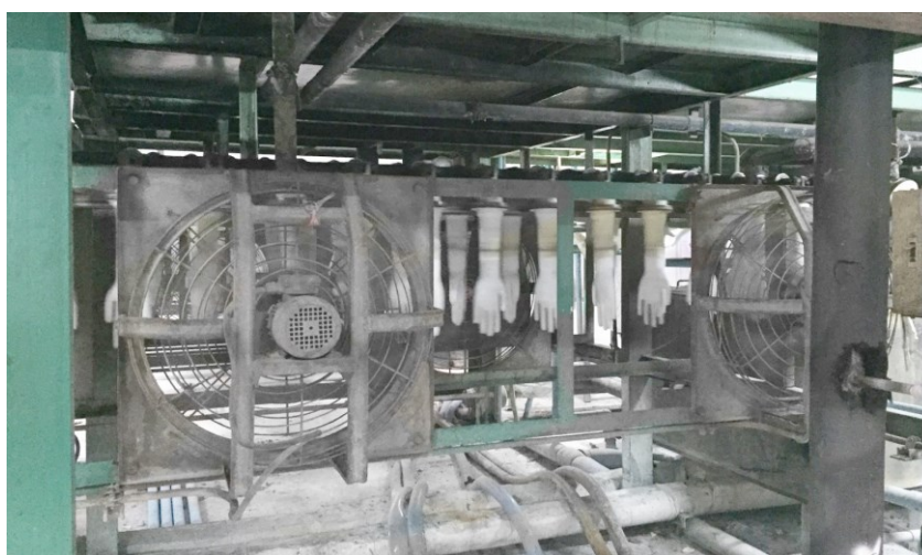
รูปที่ 4.12 การเป่าพัดลมระบายอากาศ
