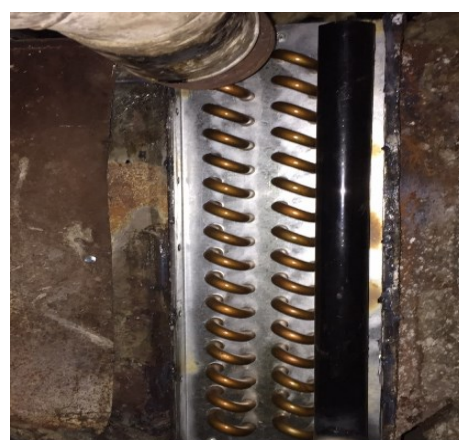
รูปที่ 4.32 คอยล์ร้อนก่อนการปรับปรุง (ก) หลังการปรับปรุง (ข)
