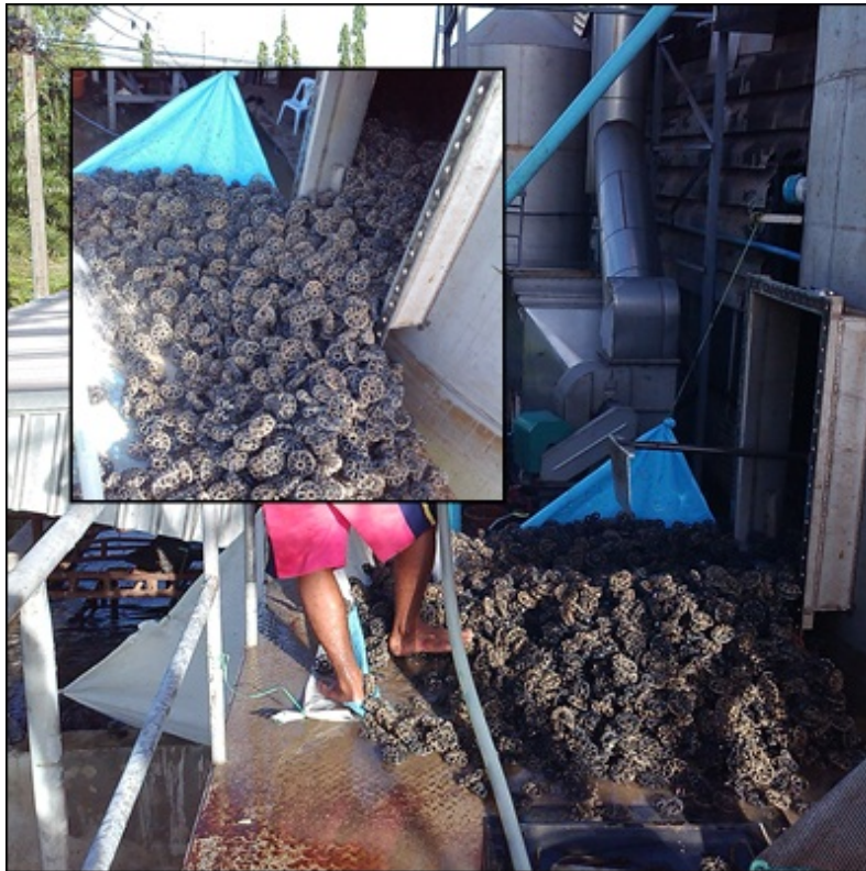
ภาพที่ 13 ลักษณะ media ที่มีตะกอนเกิดขึ้นภายในถังระบบ wet scrubber ที่ใช้ในการศึกษา
