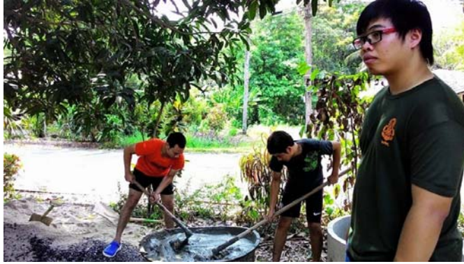
ก. การผสมปูน ทรายและหิน สำหรับใช้เพื่อเสริมความแข็งแรงของผนังบ่อก๊าซชีวภาพ
