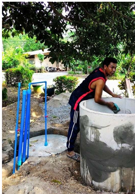
จ. บ่อก๊าซชีวภาพที่ปิดฝาและต่อท่อส่งก๊าซชีวภาพออกจากบ่อ และการเตรียมบ่อล้น สำหรับ ถ่ายเทวัสดุหมักที่ผ่านการหมักแล้วออกจากระบบ
