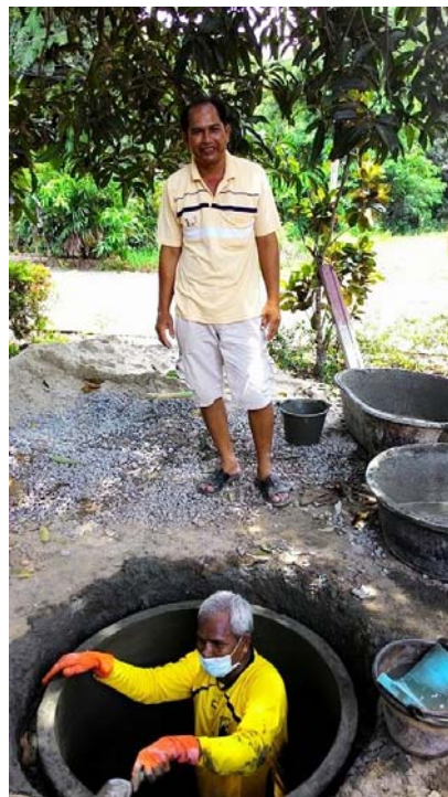
ค. การฉาบปูนด้านในบ่อเพื่อป้องกันการรั่วซึมของของเสียและก๊าซชีวภาพ
