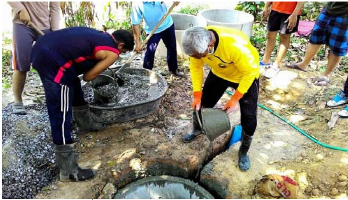
ข. การเทปูนเพื่อเสริมความแข็งแรงให้กับผนังบ่อก๊าซชีวภาพ
