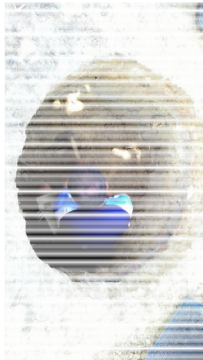
รูปที่ 3-3 การขุดและตักแต่งหลุมเพื่อสร้างระบบผลิตก๊าซชีวภาพแบบ Fixed dome
