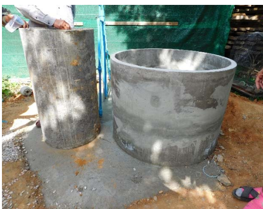
รูปที่ 4-13 กิจกรรมก่อสร้างบ่อหมักไร้อากาศ ณ กลุ่มแม่บ้านเกษตรกรรพอดาทินช้าง จ. ชุมพร
