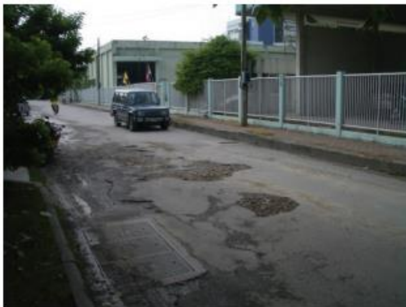
รูปที่ 2.17 ผิวถนนหน้ากรมวิชาการเกษตรที่ไม่ผสมน้ำยางพารา ที่มา : ณพรัตน์ วิชิตชลชัย และ อุดุลย์ ณ วิเชียร (2556)
