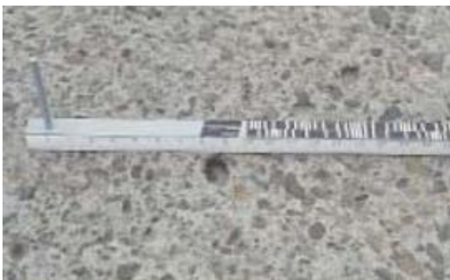
รูปที่ 2.6 การหลุดร่อนของวัสดุมวลรวม ที่มา : วีระเกษตร สอนผกา (2554)
