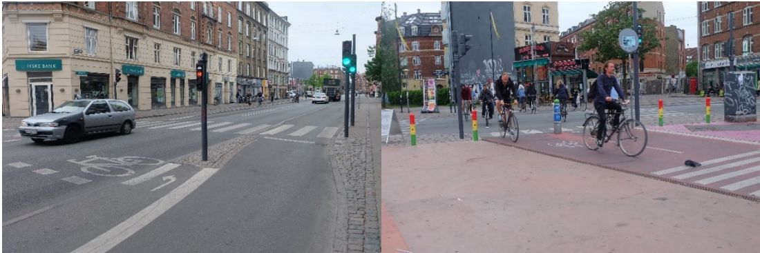
รูปที่ 2-36 สัญญาณไฟจราจรที่เหมาะสมกับระดับสายตาผู้ใช้รถจักรยาน ที่มา: ผู้วิจัย
