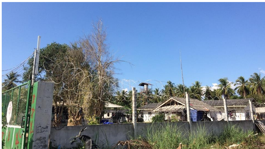
บริเวณอาคารภายนอกศูนย์บำบัดบ้านแสนสุข
