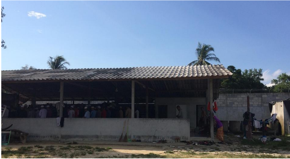
บริเวณอาคารละหมาดรวมข้างหอพักรวม
