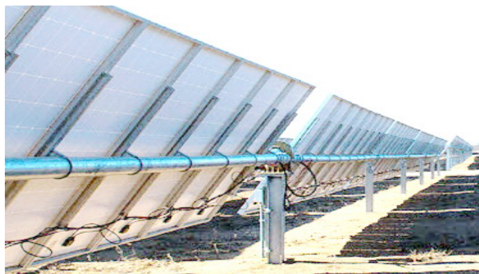
รูปที่ 4.7 โครงสร้างรองรับแผงโซลาร์เซลล์และชุดขับเคลื่อนแบบ 1 แกน
