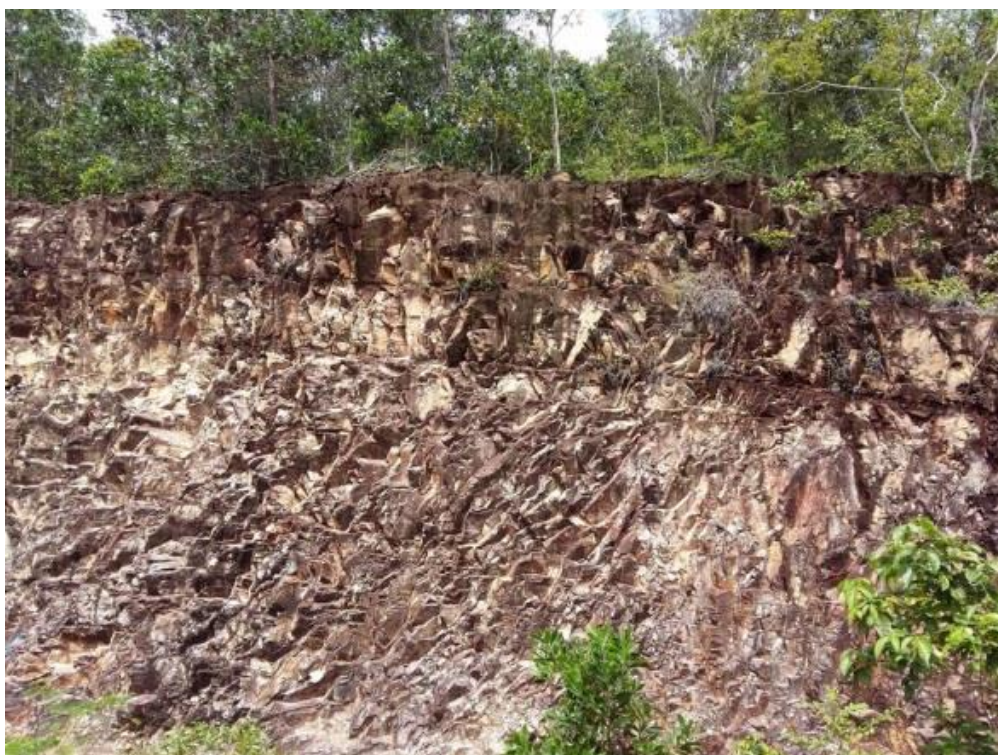
รูปที่ 13 หน้างานลาดหินทรายแทรกสลับหินดินดานหลังโรงเรียน มอ. วิทยานุสรณ์
