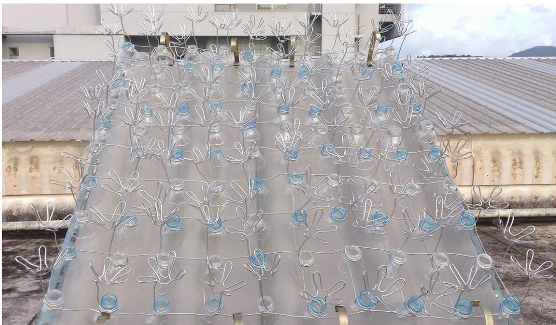
ภาพที่ 2-29 การติดตั้งแผงอุปกรณ์ปลูกพืชอากาศแบบที่ 3 ลวดอลูมิเนียมกลม บนหลังคากระเบื้องลอนคู่
