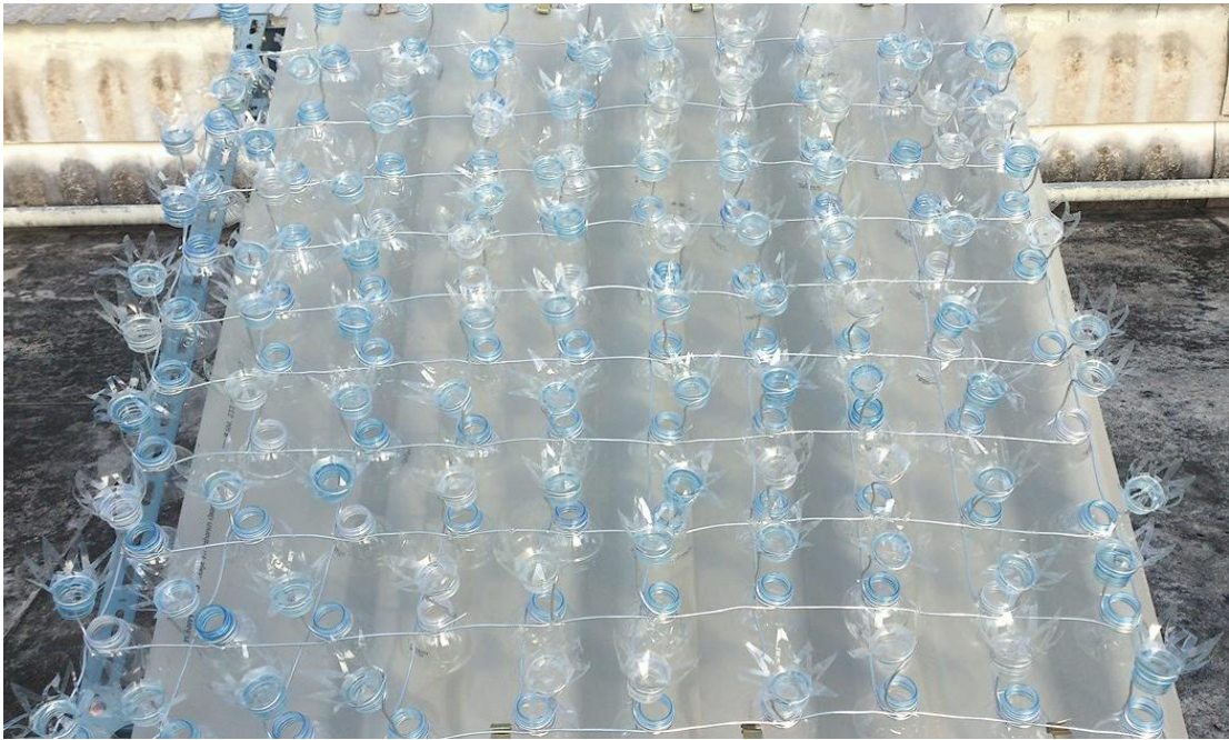
ภาพที่ 2-28 การติดตั้งแผงอุปกรณ์ปลูกพืชอากาศแบบที่ 2 ขวดน้ำพลาสติก บนหลังคากระเบื้องลอนคู่
