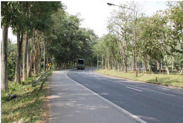
3) การเก็บปลายราวกันอันตรายไม่เหมาะสม
