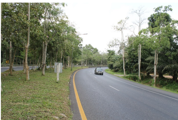
11) ความกว้างเกาะกลางไม่เหมาะสมและไม่มีการขยายขอบจราจร (Widening)
