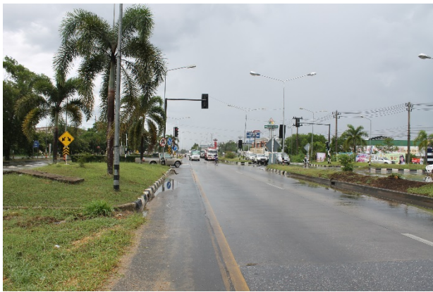
4) มีน้ำขังบนถนนเนื่องจากการระบายน้ำไม่สะดวก
