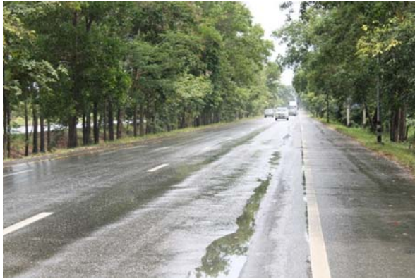
3) ผิวทางมีลักษณะความเสียหายเป็นร่องล้อ (Rutting)
