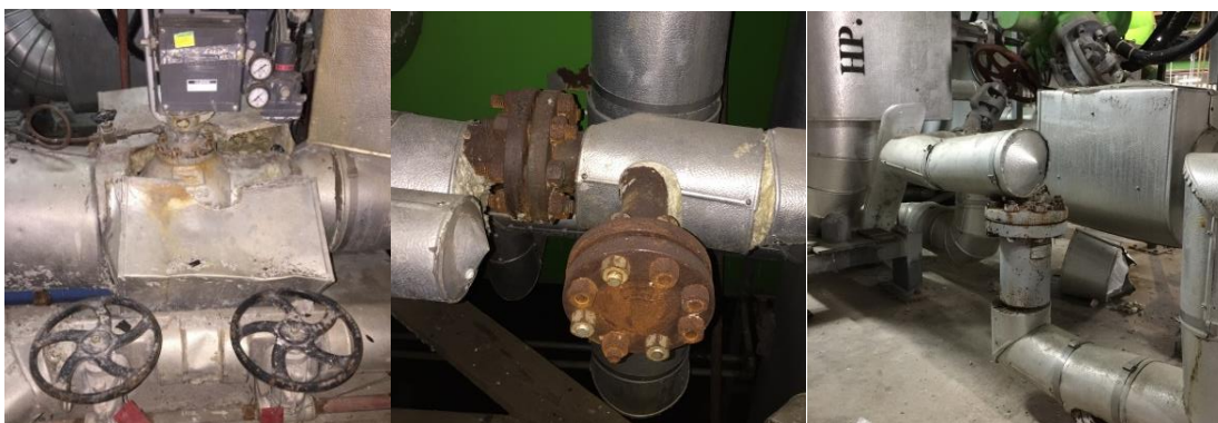
ภาพที่ 4.88 ท่อ วาล์วและหน้าแปลนที่ยังไม่มีการหุ้มและชำรุด
