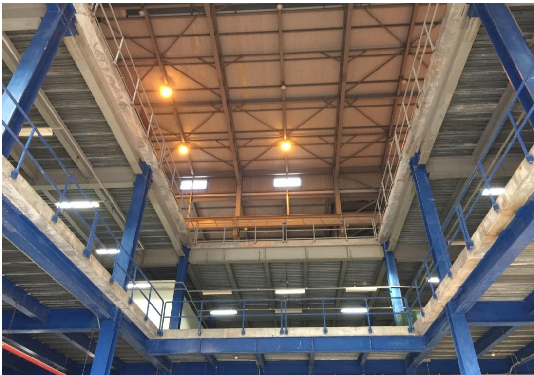
ภาพที่ 4.81 ระบบไฟฟ้าแสงสว่างที่เปิดทิ้งไว้
