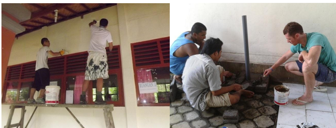
ภาพที่ 8 ภาพบรรยากาศขณะกำลังทาสีและต่อเติมบริเวณโรงเรียน ที่มา : ถ่ายโดยผู้วิจัย วันที่ 20 กุมภาพันธ์ 2558
