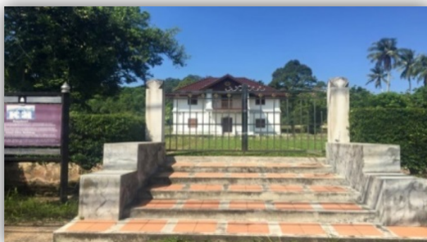
ภาพที่ 7 บ้านขุนอินทร์เป็นอาคารชิโนโปรตุกีสประยุกต์ ที่มา: ถ่ายโดยผู้วิจัยเมื่อวันที่ 29 มีนาคม 2558
