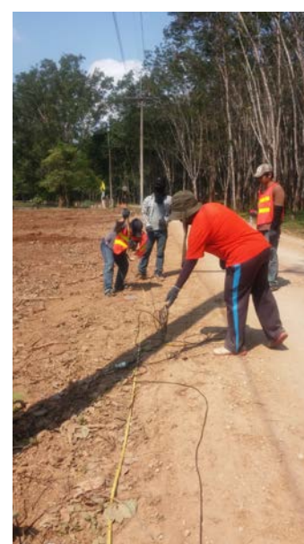
รูปที่ 3.5 (a) รูปแบบการสำรวจด้วยวิธีคลื่นไหวสะเทือนแบบสะท้อน และ (b) ภาพแสดงการเก็บข้อมูลภาคสนาม
