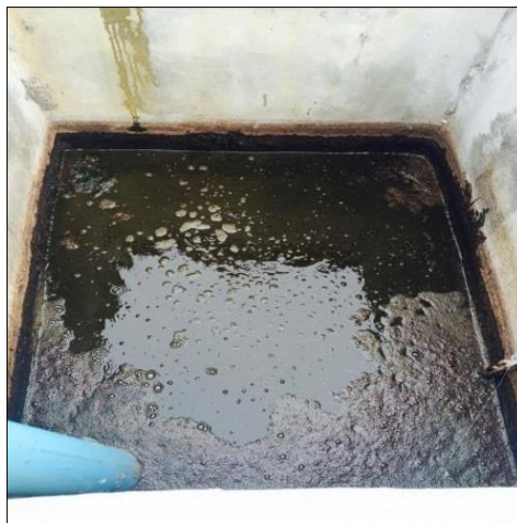
ภาพที่ 3.6 จุดติดตั้งของถังปฏิกรณ์ Chanel plug flow reactor บริษัท ปาล์มพัฒนาไบโอแก๊ส จำกัด
