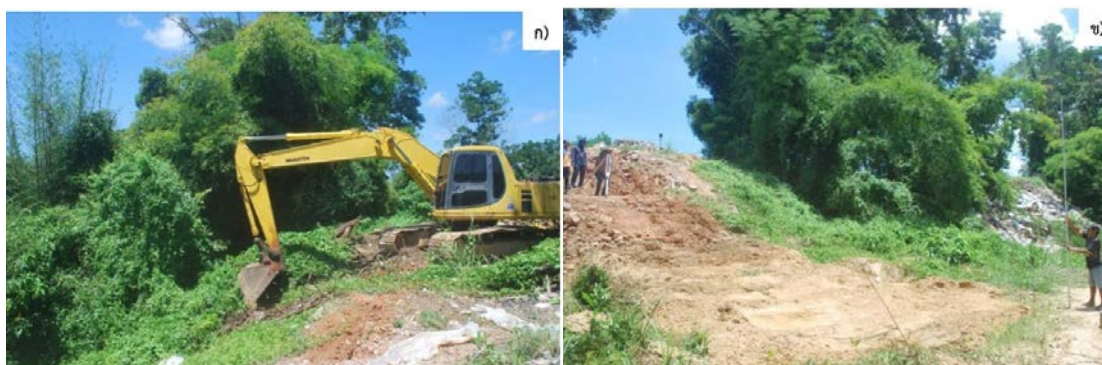
รูปที่ 5.15 การปรับพื้นที่เพื่อเตรียมการก่อสร้าง ก) การกำจัดพืชพรรณที่ปกคลุม ข) การวัดระดับด้วยกล้องสำรวจ
