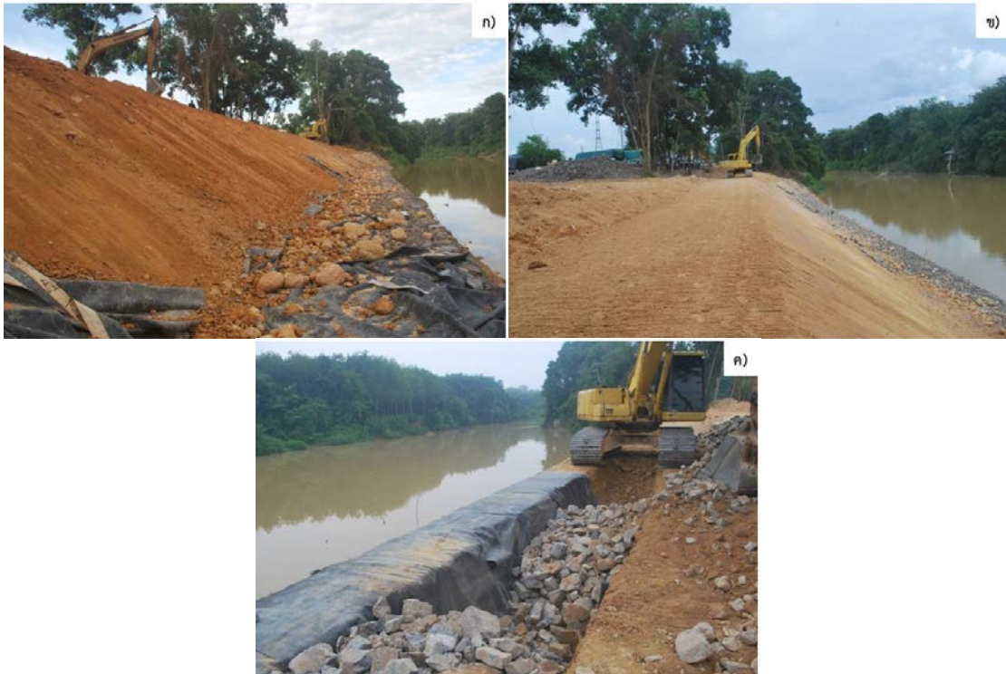
รูปที่ 5.19 การก่อสร้างแปลงสาธิตในช่วงระดับ 2.50-5.00 เมตร ก) การถมดินปรับระดับตลิ่งถึงระดับ 5.0 เมตร ข) แนวตลิ่งหลังจากปรับความชัน ค) การขุดร่องฝังแผ่นยางและเรียงหินบนตลิ่ง
