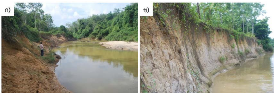
รูปที่ 3.6 คุณลักษณะทางกายภาพของตลิ่งบริเวณพื้นที่ลุ่มน้ำบริเวณกลางน้ำ ก) บ้านคลองปอม (UT4) ข) บ้านพรุ (UT8)
