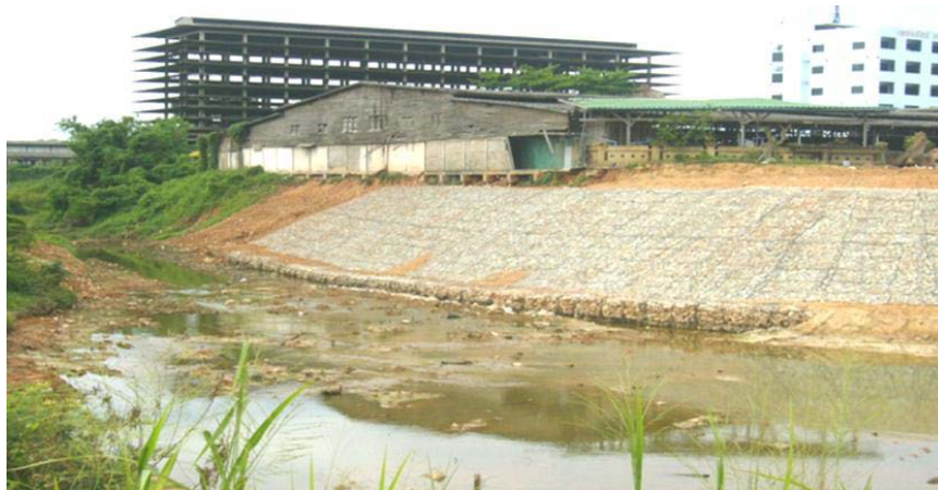
รูปที่ 2.23 การใช้เกเบียนในการป้องกันการกัดเซาะตลิ่ง
