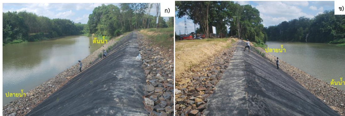
รูปที่ 5.24 ลักษณะของแปลงสาธิตหลังจากการก่อสร้างเสร็จสมบูรณ์เป็นระยะเวลา 3 เดือน (มกราคม 2559) ก) มองจากปลายน้ำ ข) มองจากต้นน้ำ
