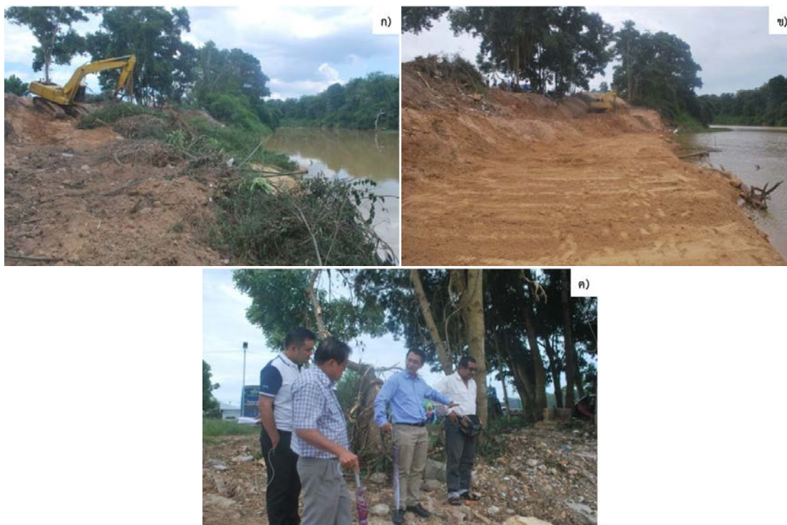
รูปที่ 5.16 การเปิดพื้นที่แนวตลิ่งที่ทำการปรับปรุง ก) การเคลียร์พื้นที่บริเวณตลิ่ง ข) แนวตลิ่งหลังจากการปรับพื้นที่แล้ว ค) คณะผู้ร่วมดำเนินการก่อสร้างการปรับปรุงตลิ่ง
