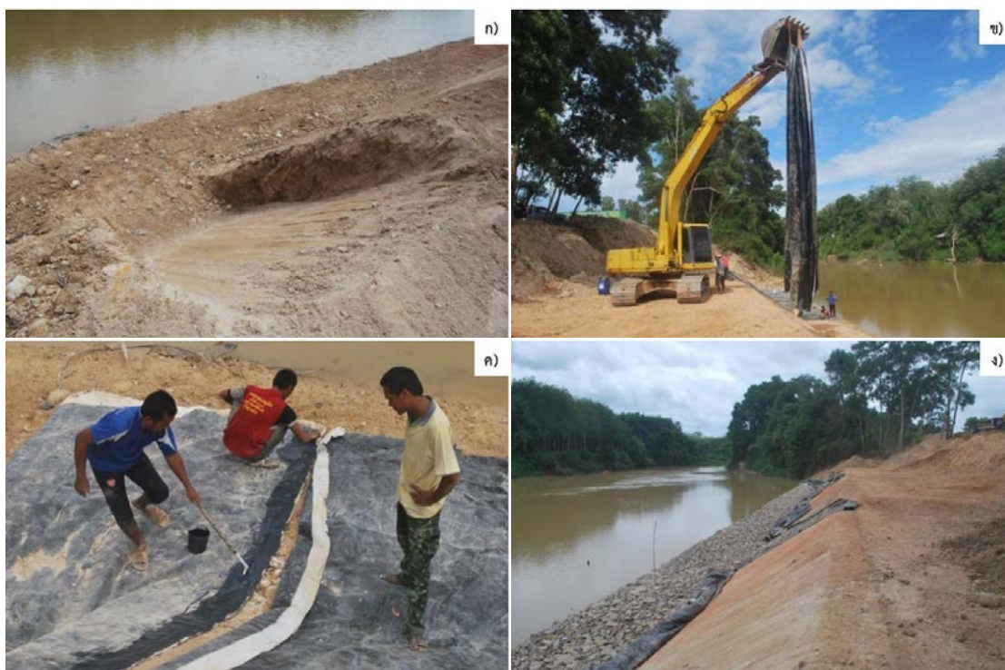
รูปที่ 5.18 การก่อสร้างแปลงสาธิตในช่วงระดับตีนตลิ่งถึงระดับ +2.50 เมตร ก) ร่องทางเข้า-ออกแปลง สาธิต ข) การเคลื่อนย้ายแผ่นยางเพื่อปูตลิ่ง ค) การทาขาวายบริเวณรอยต่อ ง) แนวตลิ่ง หลังจากการปูยางและเรียงหินแล้ว
