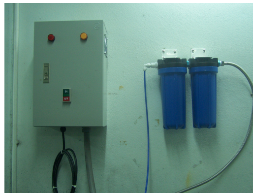
รูปที่ 3.6 แสดงระบบหล่อเย็นเครื่องขัด
