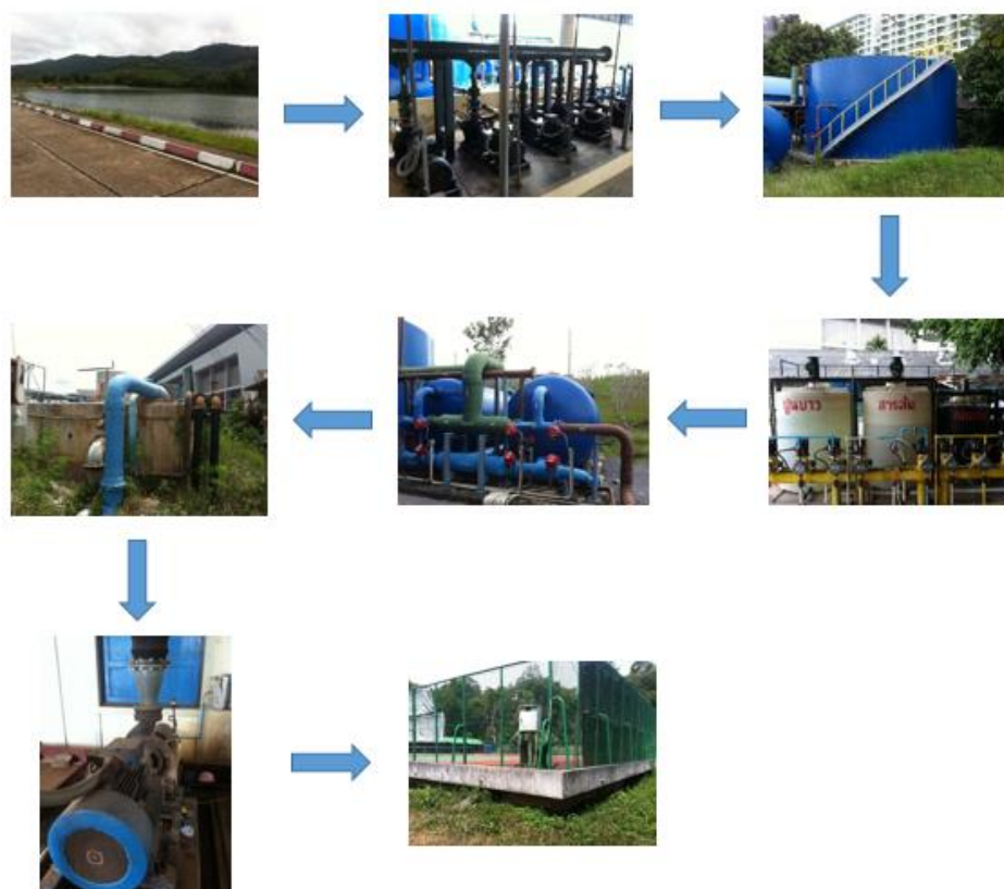
ภาพประกอบ 2-2 กระบวนการผลิตน้ำประปาในมหาวิทยาลัยสงขลานครินทร์ วิทยาเขตหาดใหญ่
