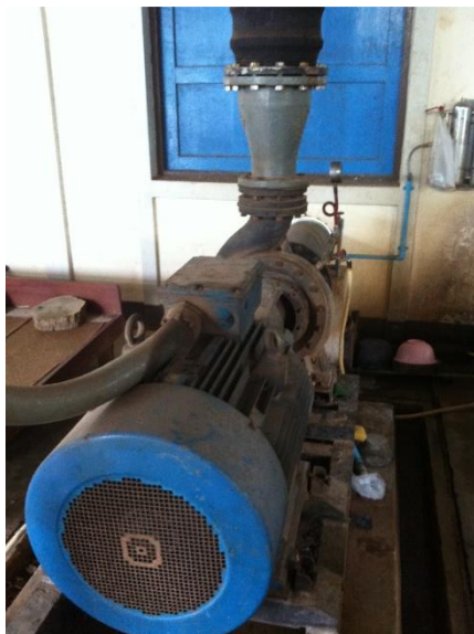
ภาพประกอบ 2-9 มอเตอร์สูบน้ำขึ้นแท็งก์ขนาดใหญ่ ภาพประกอบ 2-10 แท็งก์น้ำขนาดใหญ่
