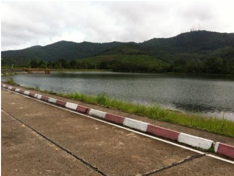
ภาพประกอบ 2-3 อ่างเก็บน้ำศรีตรัง
