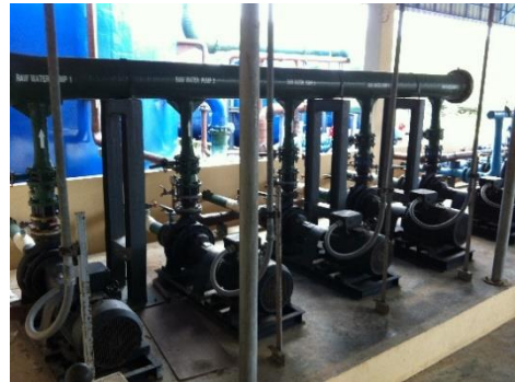
ภาพประกอบ 2-4 ปั๊มดูดน้ำจากอ่างเก็บน้ำศรีตรัง
