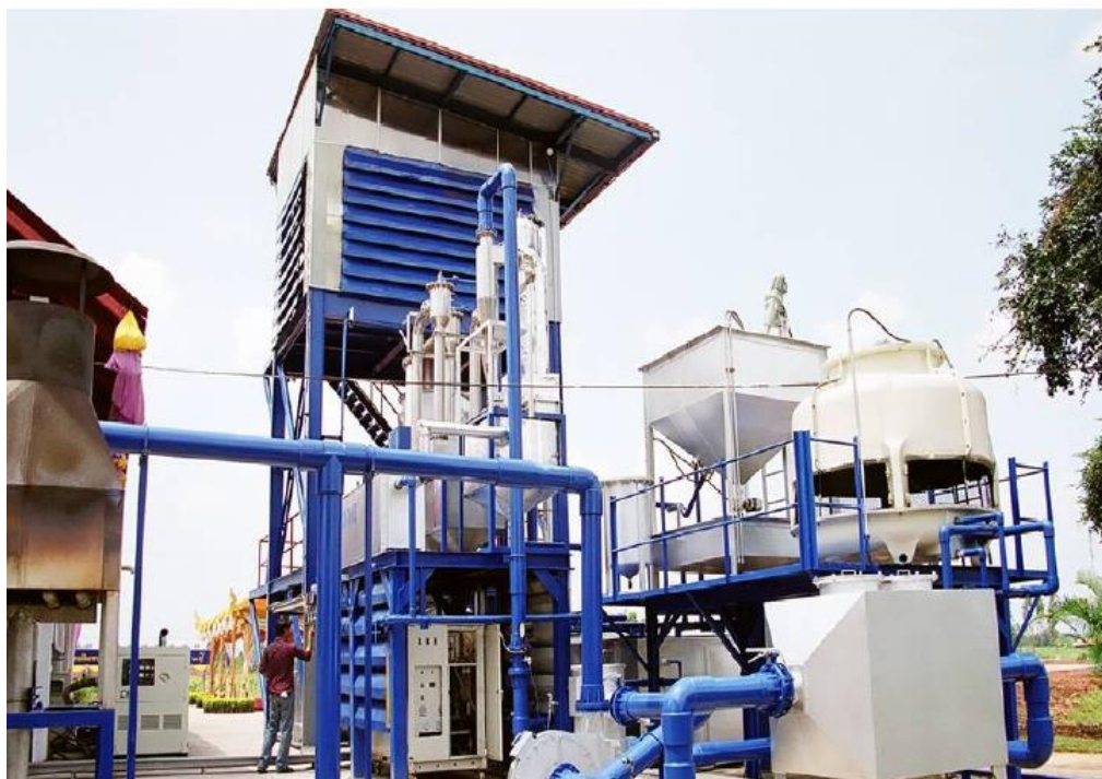
รูปที่ ค-7 โรงไฟฟ้าชีวมวลขนาดเล็กสำหรับชุมชน มหาวิทยาลัยเทคโนโลยีสุรนารี ที่มา: ศูนย์ความเป็นเลิศทางด้านชีวมวล มหาวิทยาลัยเทคโนโลยีสุรนารี, 2548
