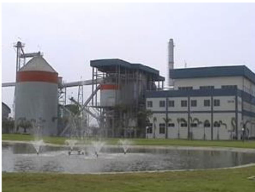
รูปที่ ค-8 โรงไฟฟ้าชีวมวลขนาดเล็ก บริษัท มุ่งเจริญกรีนเพาเวอร์ จำกัด ที่มา: ศูนย์ส่งเสริมพลังงานชีวมวล มูลนิธิพลังงานเพื่อสิ่งแวดล้อม, 2548
