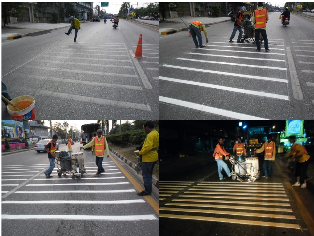
รูปที่ 4-14 การติดตั้งเส้นชะลอความเร็ว (Rumble Strips)
