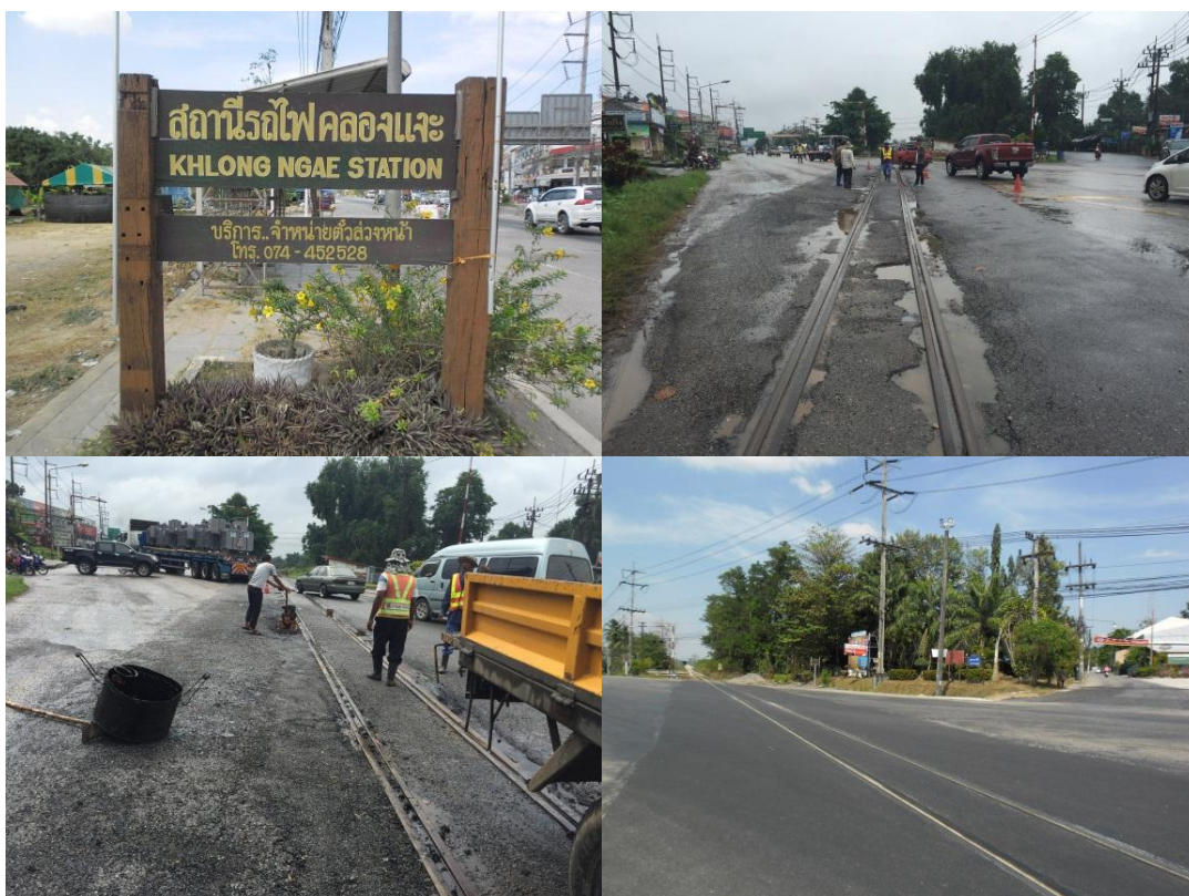
รูปที่ 4-31 งานซ่อมแซมผิวทางชำรุดจุดตัดทางรถไฟ
