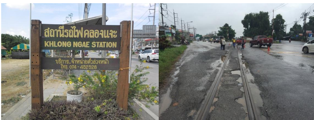
รูปที่ 4-28 ลักษณะตำแหน่งจุดเสี่ยงอันตราย จุดตัดทางรถไฟ
