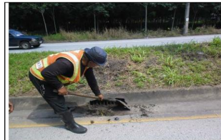
รูปที่ 9 การทำความสะอาดช่องระบายน้ำ
