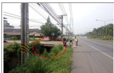
รูปที่ 12 จุดเปิดท่อระบายน้ำคอนกรีต
