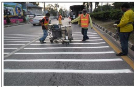
รูปที่ 7 การติดตั้งเส้นระนาบ (Rumble Strips)
