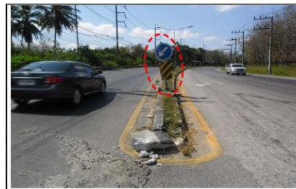
รูปที่ 10 ป้ายจราจรชำรุดและไม่ได้มาตรฐาน
