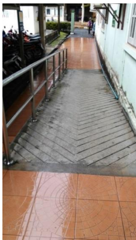
ภาพประกอบ 4.64 ทางลาดบริเวณอาคารเทศบาลเมืองทุ่งสง
