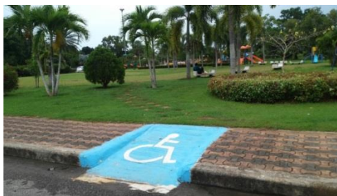
ภาพประกอบ 4.57 ทางลาดสำหรับผู้สูงอายุบริเวณสวนหลวงร.๕ สุราษฎร์ธานี
