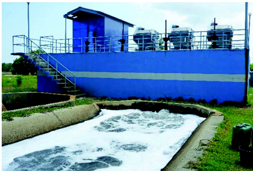
ภาพประกอบที่ 3-1 บ่อรวบรวมน้ำเสียชุมชนระบบปรับปรุงคุณภาพน้ำ เทศบาลนครหาดใหญ่ จังหวัดสงขลา
