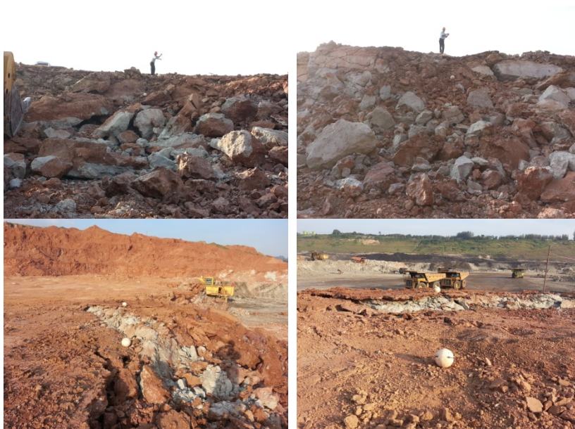
รูปที่ ฉ-7 ผลการระเบิดวันที่ 21 เดือนพฤศจิกายน พ.ศ.2557 ที่ 18 มิลลิวินาที
