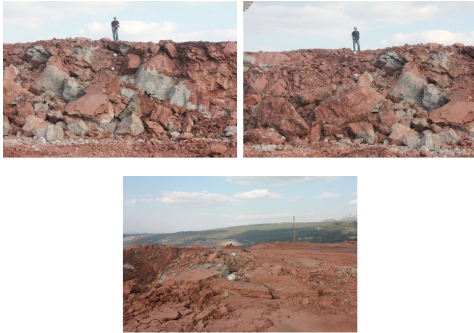
รูปที่ ง-1 ผลการระเบิดวันที่ 20 เดือนธันวาคม พ.ศ.2556 air deck 10%
