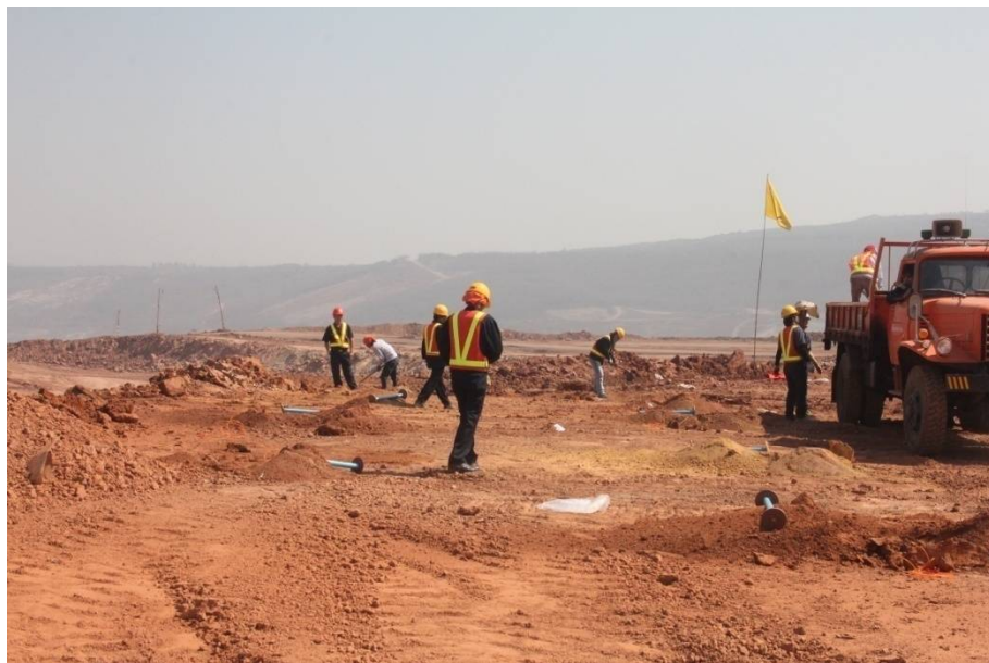
รูปที่ 2.21 การเตรียมหน้างานสำหรับการระเบิดโดยใช้เทคนิคการเว้นช่องว่างอากาศภายในรูเจาะ
