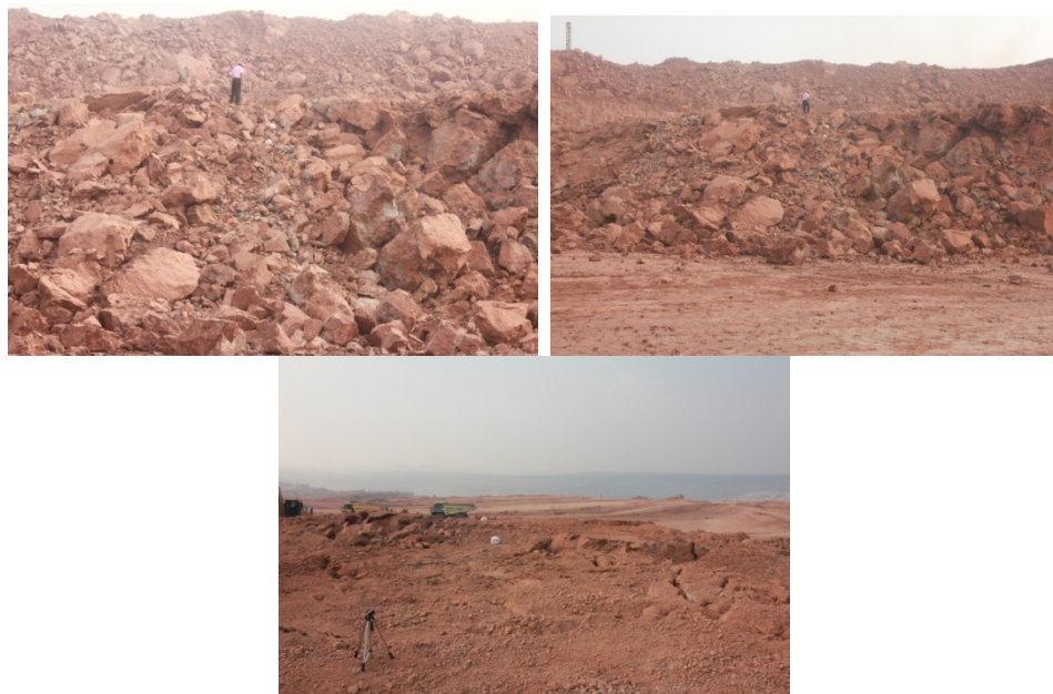
รูปที่ ค-3 ผลการระเบิดวันที่ 19 เดือนพฤศจิกายน พ.ศ.2556 แบบขยายระยะห่างระหว่าง รูเจาะ
