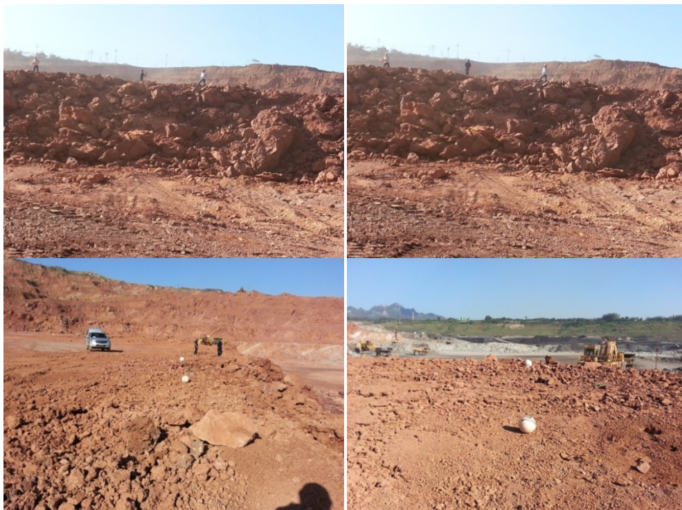
รูปที่ 3.17 ผลการระเบิดโดยใช้หลักการ Waveform interference ถ่วงจังหวะที่ 10 มิลลิวินาที
