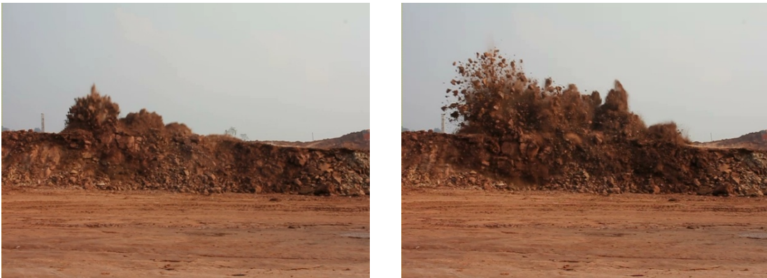
รูปที่ 4.2 การพุ่งขึ้นด้านบนของดินของการระเบิดโดยการแบ่งวัตถุระเบิดออกเป็นช่วง
