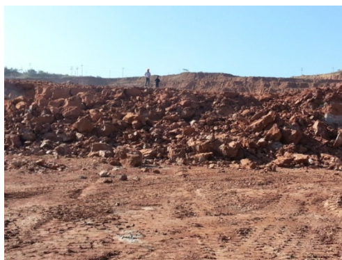
รูปที่ 3.17 ผลการระเบิดโดยใช้หลักการ Waveform interference ถ่วงจังหวะที่ 10 มิลลิวินาที
