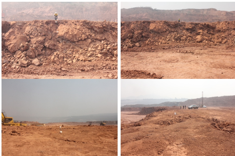
รูปที่ ง-4 ผลการระเบิดวันที่ 24 เดือนกุมภาพันธ์ พ.ศ.2557 air deck 12.5%
