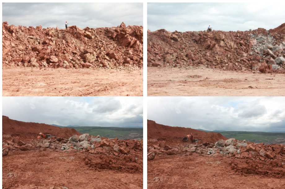
รูปที่ จ-1 ผลการระเบิดวันที่ 16 เดือนสิงหาคม พ.ศ.2556 แบบ 1.5 เมตร : 2.5 เมตร
