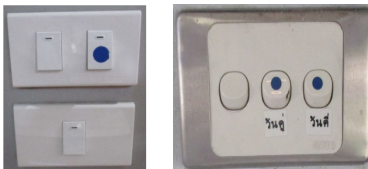
รูปที่ 4.6 สัญลักษณ์ติดที่สวิตช์ไฟกำหนดให้เปิด
