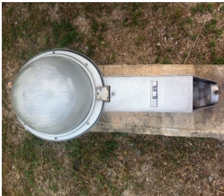
รูปที่ 3.6 การถอดโคมไฟถนนเมทัลฮาไลด์ (Street light) ขนาด 250 วัตต์
