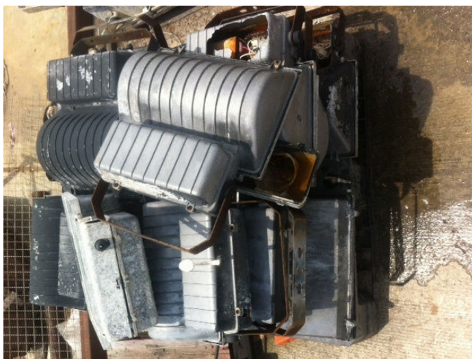
รูปที่ 3.17 โคมไฟส่องสนามเมทัลฮาไลด์ (Flood light) ขนาด 400 วัตต์ ที่ถอดออกมา
