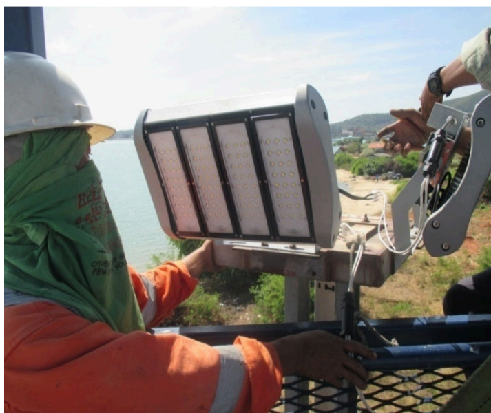
รูปที่ 3.19 การเปลี่ยนโคมไฟส่องสนาม LED (Flood light) ขนาด 200 วัตต์
