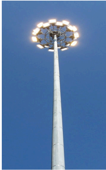
รูปที่ 3.33 การนำโคมไฟเสาสูงไฟฟ้าแรงสูง LED ขึ้นสู่ยอดเสา
