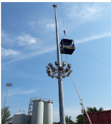
รูปที่ 3.24 การนำโคมไฟเสาสูงไฟฟ้าแรงสูงโดยใช้รถเครน
