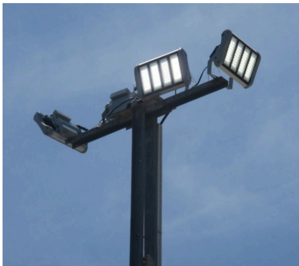
รูปที่ 3.20 การทดสอบโคมไฟส่องสนาม LED (Flood light) ขนาด 200 วัตต์
