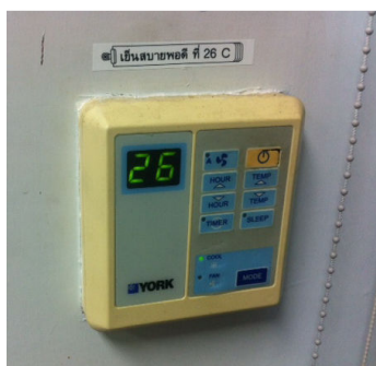
รูปที่ 4.8 การติดสติ๊กเกอร์เปิดแอร์ที่อุณหภูมิ 26°C ในห้องทำงานของพนักงาน
