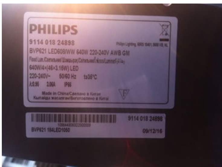
รูปที่ 3.30 Name plate โคมไฟเสาสูงไฟฟ้าแรงสูง LED (High mast) ขนาด 640 วัตต์
