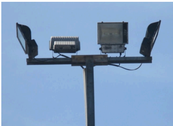
รูปที่ 3.16 โคมไฟส่องสนามเมทัลฮาไลด์ (Flood light) ขนาด 400 วัตต์
