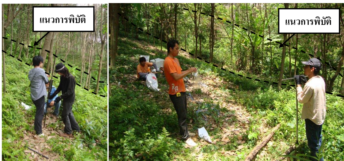
(ข) ทดสอบกำลังรับน้ำหนักของดินด้วยวิธีเจาะหยั่งแบบเบ้า Kunzelstab Penetration Test ทางด้านซ้ายของรอยพิบัติบริเวณตำแหน่ง T
