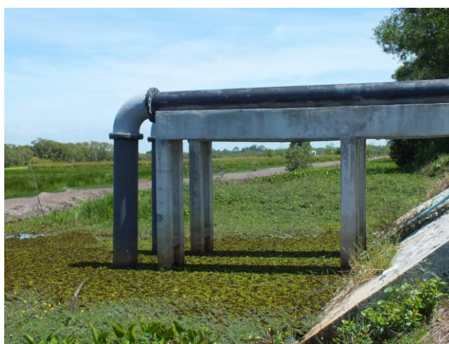
ภาพประกอบ 16 ระบบสูบน้ำจากคลองเชิงแสกระจายเข้าสู่เหมืองส่งน้ำ
