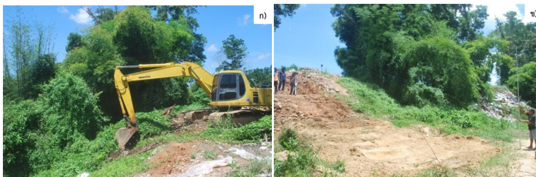
รูปที่ 5.15 การปรับพื้นที่เพื่อเตรียมการก่อสร้าง ก) การกำจัดวัชพื้และปรับพื้นที่ ข) การวัดระดับด้วยกล้องสำรวจ
