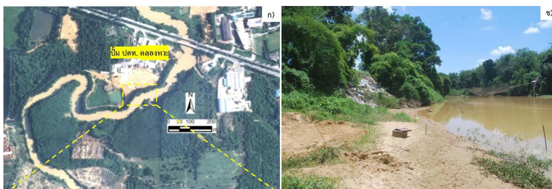
รูปที่ 5.5 แนวตลิ่งในพื้นที่ดำเนินการก่อสร้างการปรับปรุงเสถียรภาพของตลิ่งคลองอุตะเถา ก) ภาพถ่ายทางอากาศในปี 2553 ข) สภาพตลิ่งปัจจุบัน
