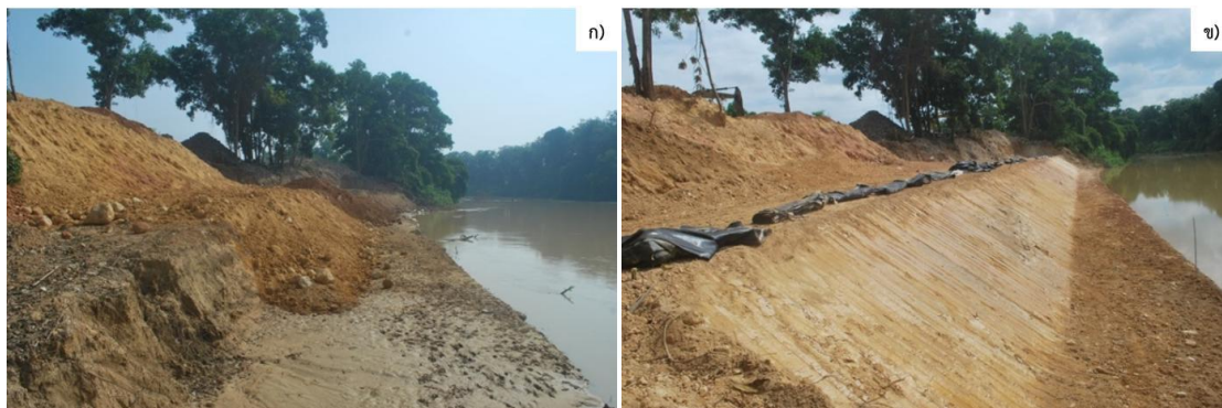
รูปที่ 5.17 การถมดินเพื่อปรับระดับของตลิ่งในชั้นล่าง ก) แนวตลิ่งก่อนเริ่มทำการถมดินปรับระดับ ข) แนวตลิ่งหลังจากการถมดินปรับระดับจากตีนตลิ่งถึงระดับความสูง 2.5 เมตร
