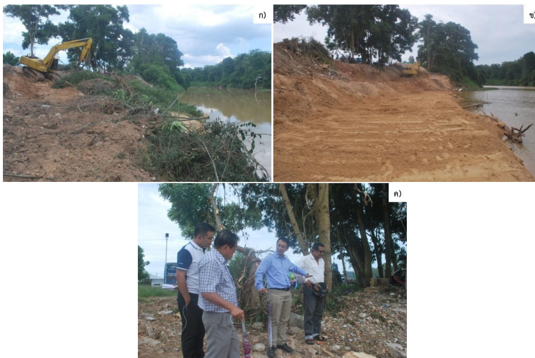
รูปที่ 5.16 การเปิดพื้นที่แนวตลิ่งที่ทำการปรับปรุง ก) การเคลียพื้นที่บริเวณตลิ่ง ข) แนวตลิ่งหลังจากการปรับปรุงพื้นที่แล้ว ค) คณะผู้ร่วมดำเนินการก่อสร้างการปรับปรุงตลิ่ง
