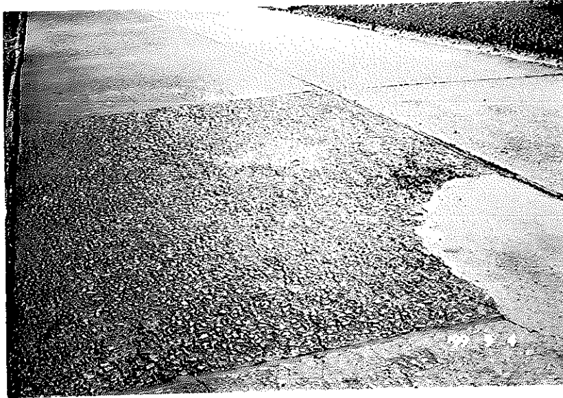
ภาพประกอบ ข.1 ผิวหน้าหลุดร่อน (Scaling)
