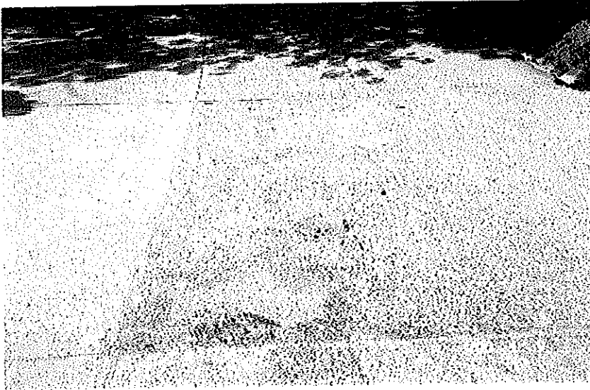
ภาพประกอบ ช.3 แตกเป็นหลุมบ่อ (Popouts)
