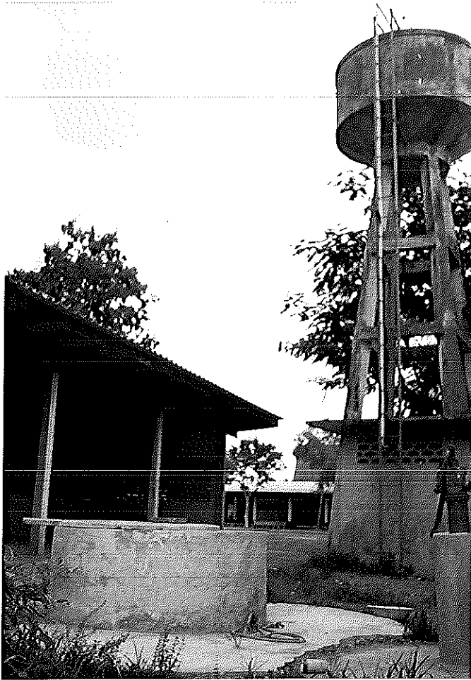
ภาพประกอบ 8 ประปาชุมชนที่สร้างขึ้นบริเวณโรงเรียน
