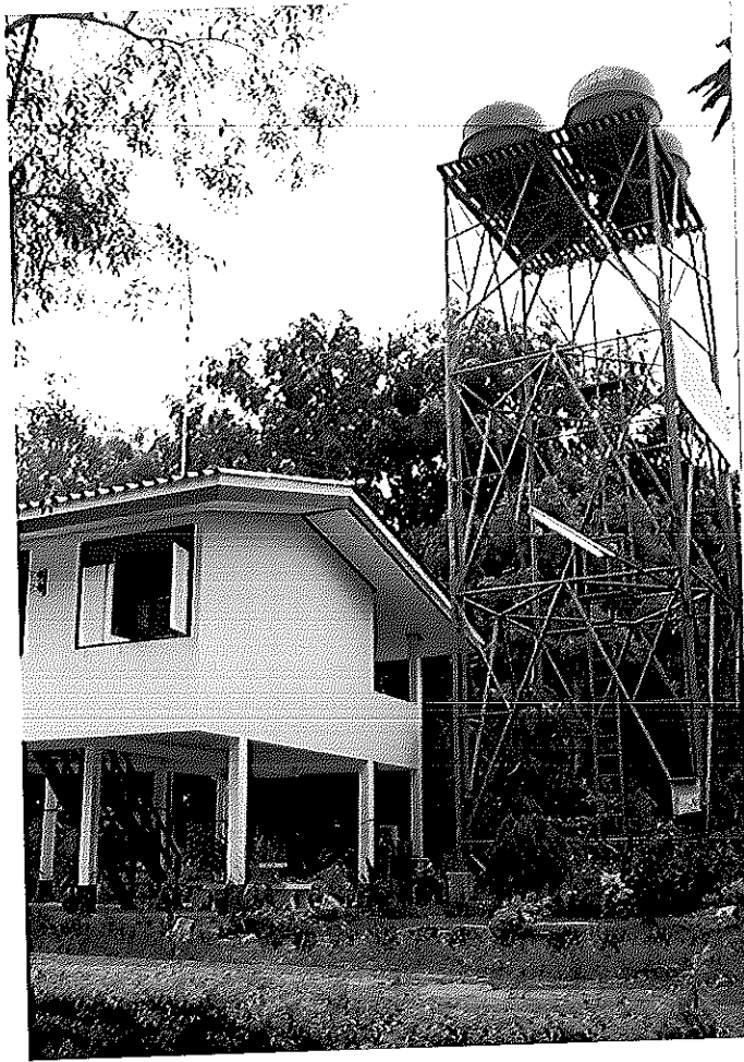
ภาพประกอบ 16 ประปาชุมชนที่ไม่ได้ใช้ประโยชน์ เพราะถังประปาชำรุดเสียหาย
