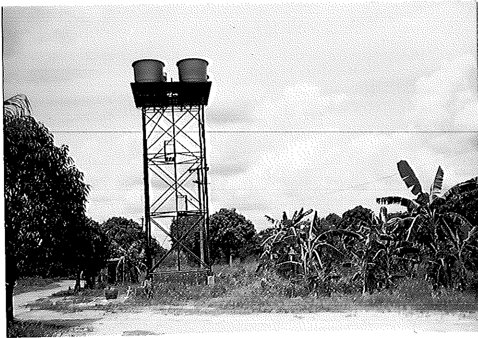
ภาพประกอบ 6 ประปาชุมชนที่สร้างในบริเวณที่ดินสาธารณะ
