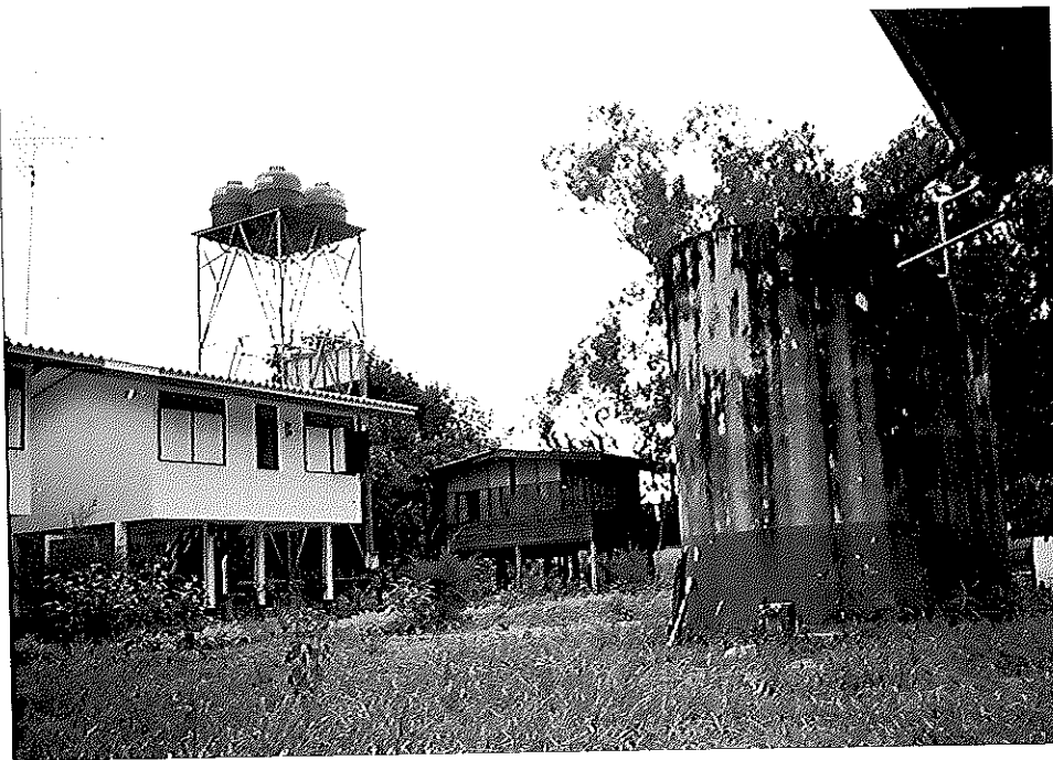
ภาพประกอบ 7 ประปาชุมชนที่สร้างในบริเวณสถานีอนามัย
