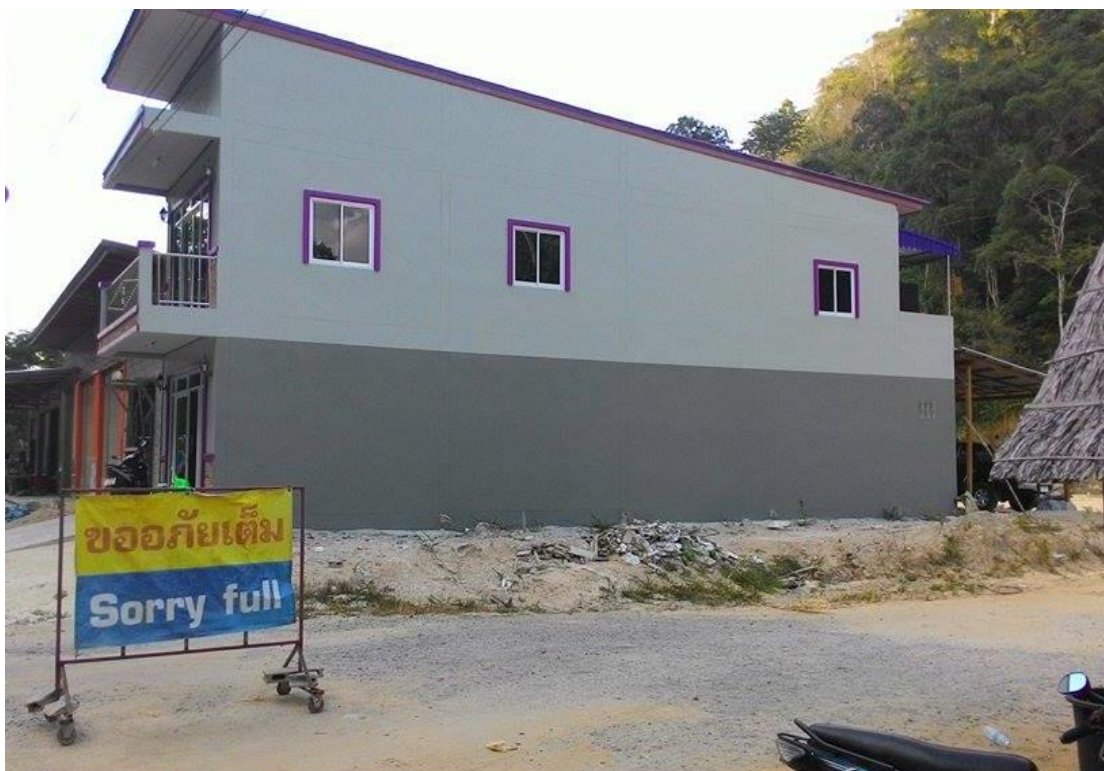
ภาพประกอบ 23 การก่อสร้างอาคารที่มั่นคงมีเพิ่มขึ้นในพื้นที่
