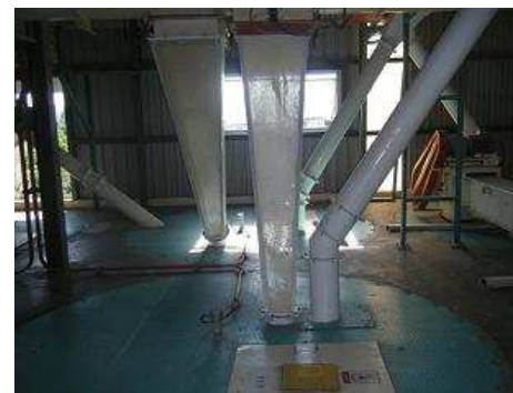
(D) Flour Transfer pipe after improvement
