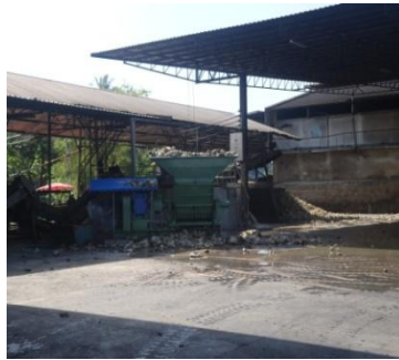
B.เครื่องตัดก้อนยาง (Pre-breaker)
