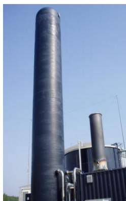
รูปที่ 2.10 กระบวนการดูดซึมก๊าซคาร์บอนไดออกไซด์ด้วยน้ำแบบ Water Scrubbing [3]
