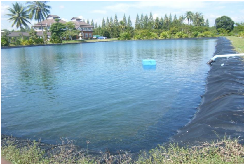
รูปที่ 16. บ่อพักน้ำที่เป็นบ่อดินที่ สวพท. ขนาด 12x20x3 เมตรปูด้วยพลาสติก
