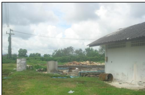
ช.จุดบำบัดน้ำเสีย
