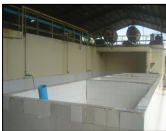
ข. บ่อรับน้ำยางสด
