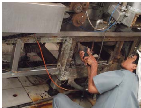
(A) การทำความสะอาดฐานของเครื่องจักร
