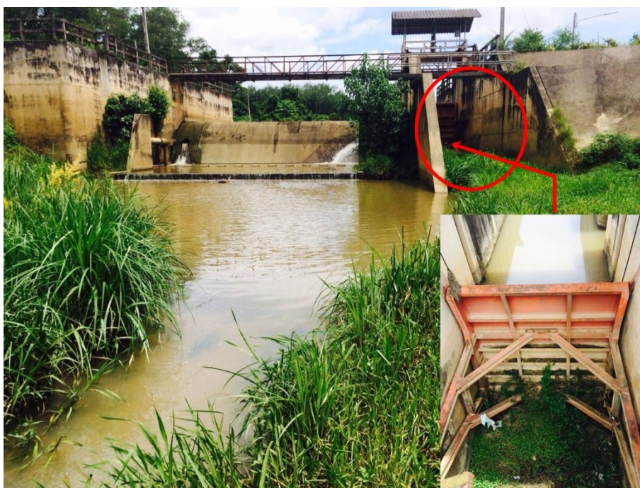
ภาพที่ 5 ฝายทดน้ำคอนกรีตและประตูเปิด-ปิดน้ำ ในหมู่ที่ 5 บ้านทุ่งเลียบ ตำบลคลองหอยโข่ง ที่ผันน้ำลงสู่พื้นที่ตำบลโคกม่วง อำเภอคลองหอยโข่ง จังหวัดสงขลา
