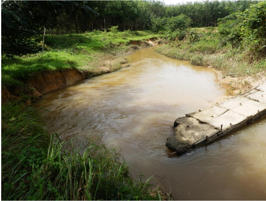
ภาพที่ 8 ลักษณะฝายที่พังทลายในพื้นที่ของหมู่ที่ 6 บ้านพรุเตาะ ที่มา : ถ่ายโดย ผู้วิจัย 9 ตุลาคม 2554
